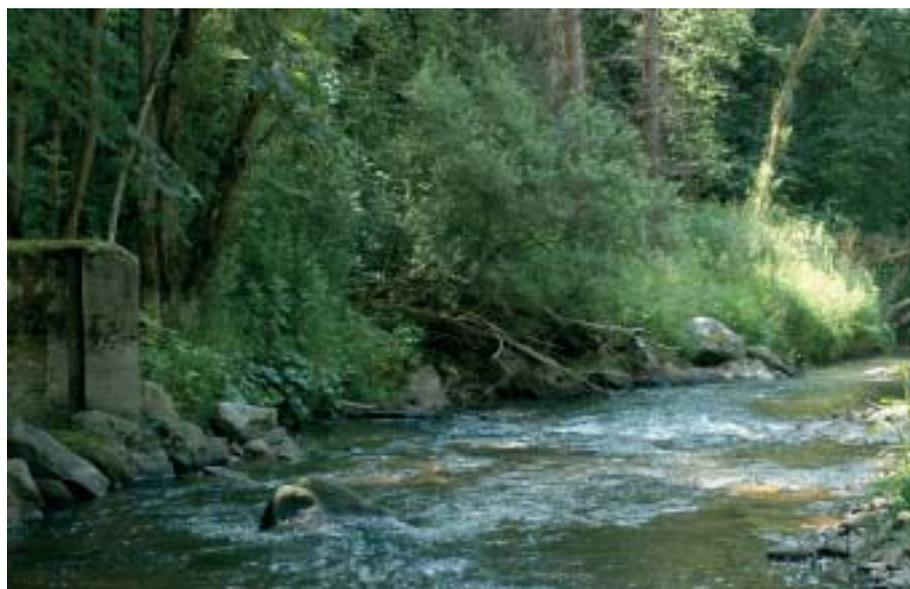
Abbildung 14: Ehemaliger Wehrbereich knapp 3 Jahre nach dem Rückbau (Foto stromab)
