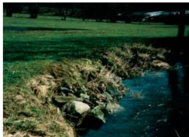
Abbildung 5: Begradigter Abschnitt der Mitternacher Ohe mit Uferbefestigung
