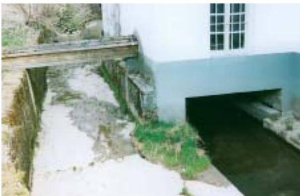
Abbildung 11: Hochwasserentlastungskanal
