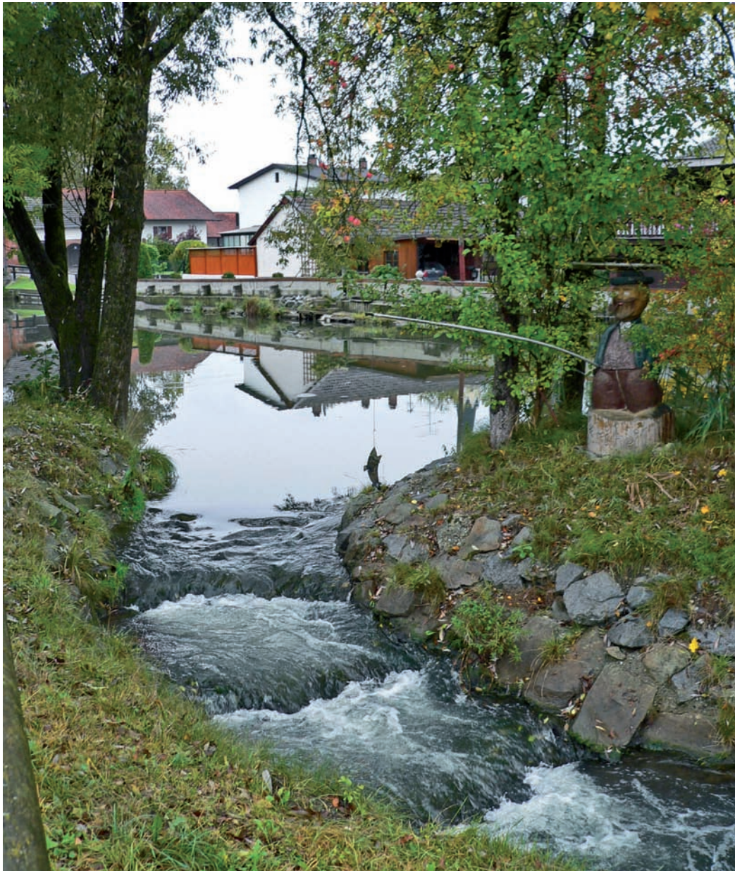
Fischaufstiegsanlagen helfen einem Teil der Fische, das Kraftwerk stromauf zu umgehen.
