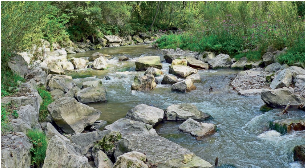
Strukturvielfalt im Fließgewässer fördert den Erhalt bzw. die Wiederansiedlung charakteristischer Tier- und Pflanzenarten.
