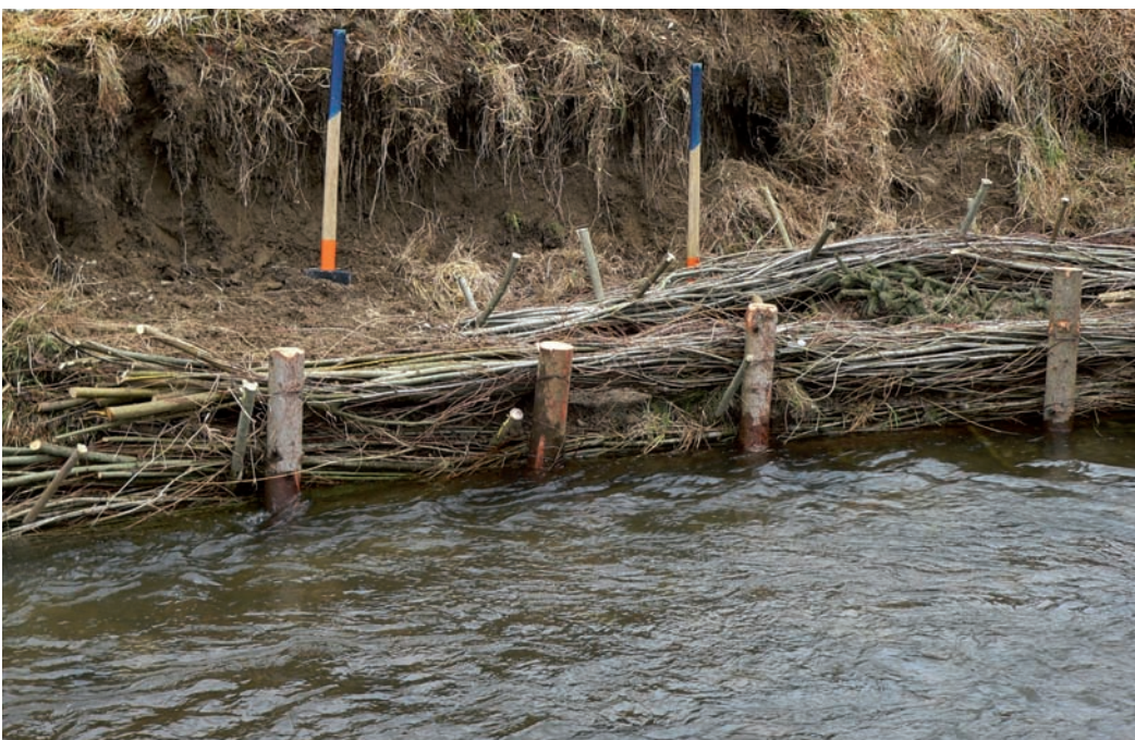
Verbesserung der Uferstruktur. Wird eine harte Verbauung durch ingenieurbioökologische Bauweisen ersetzt, können wertvolle Fischunterstände geschaffen und die Uferstabilität beibehalten werden.
