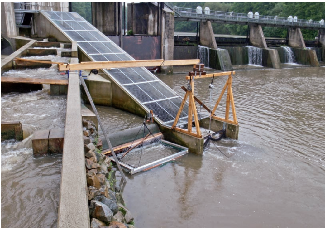
Der Fischabstieg - hier bei einer Beprobung durch den LFV Bayern an der niederbayerischen Vils. Die erforderliche Technik (in diesem Fall über eine Spülrinne, links, und eine Wasserkraftschnecke, rechts) steckt noch in den Anfängen und muss mit Nachdruck weiterentwickelt werden.
