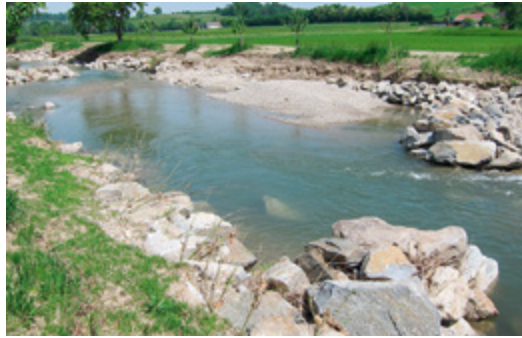
Links: Einbau von Störsteinen in einem Huchen-Gewässer (Ilz)
