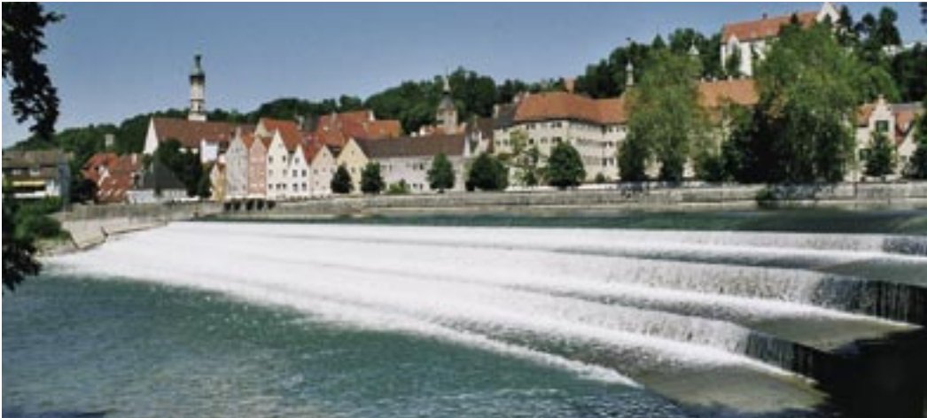
Karolinenwehr in Landsberg am Lech: erste Erwähnung im 14. Jahrhundert. Heute mit einem 200 m Tümpelpass als Fischaufstiegshilfe ausgestattet
